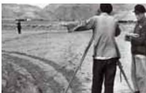
▲测量厂房位置
