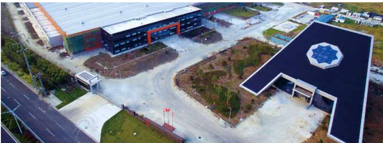
蚌埠铜铟硒薄膜太阳能高效模组生产基地全景
