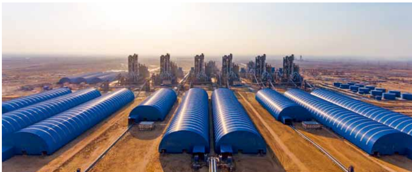
埃及GOE6条日产6000吨熟料水泥生产线全景
