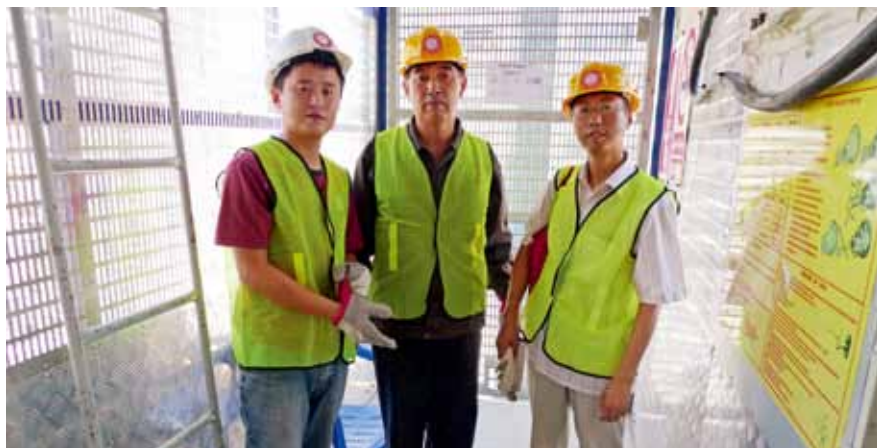
在施工升降机里维修
