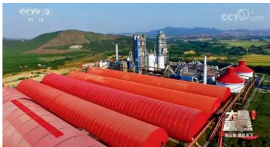
取景拍摄徐州中联双万吨水泥线
