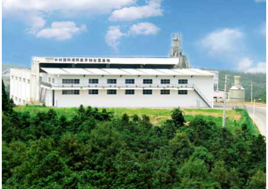
溧阳市危废无害化协同处置3万吨项目
