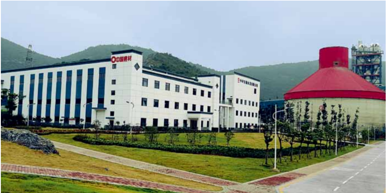
中材安徽水泥有限公司利用水泥窑无害化协同处置巢湖市日处理500吨生活垃圾项目
