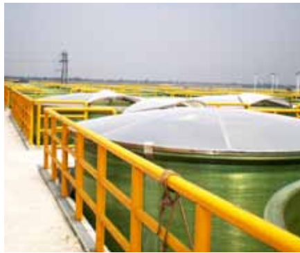
玻璃钢酿造罐
