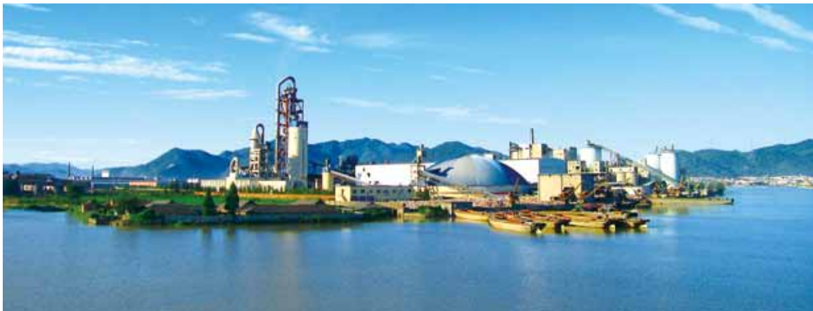
中国建材污泥处理生产线被誉为“水乡明珠”
