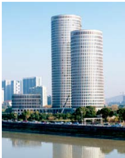
矗立在西湖边上的杭州生物医药创业陶瓷薄板基地，采用陶瓷板外墙干挂，是国内首家采用陶瓷幕墙的高层节能建筑
