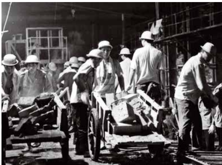
洛阳玻璃厂浮法线早期生产现场
