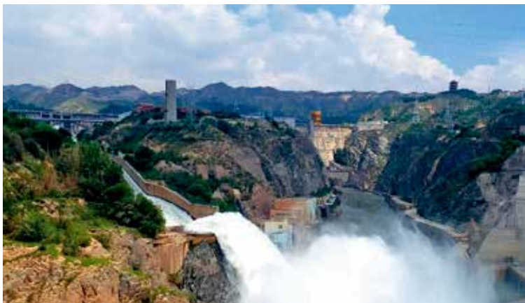
亚洲最大的水电站——刘家峡水电站
